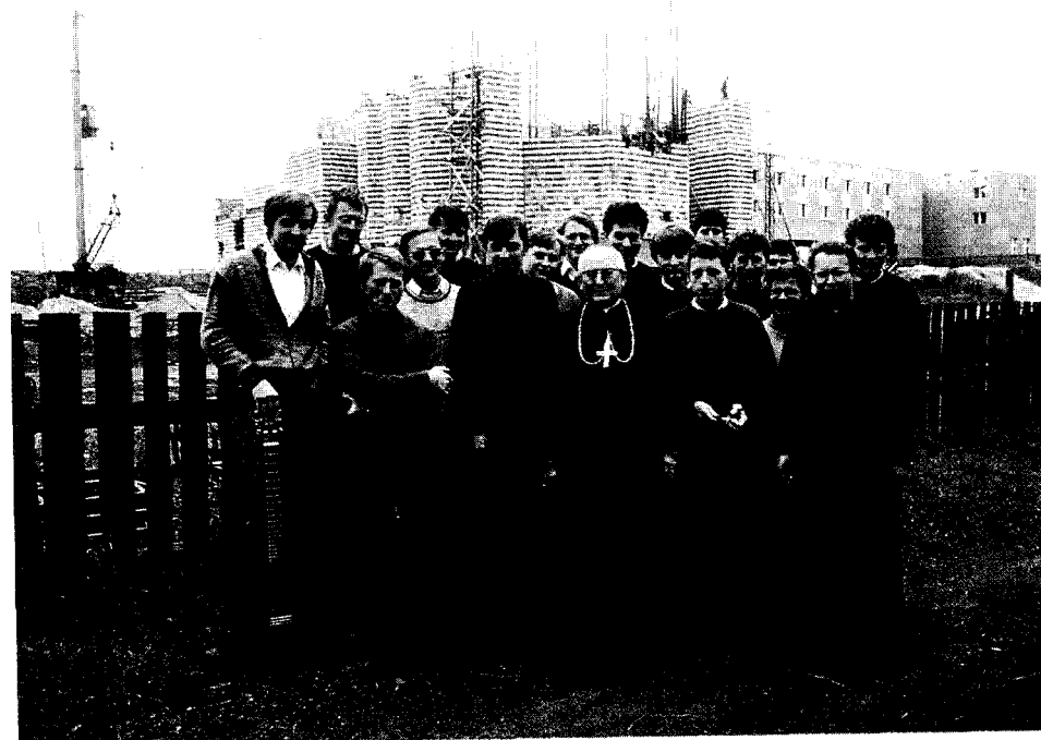
Koszalin-Wilkowo, wrzesień 1986. Na budowie Wyższego Seminarium Duchownego z klerykami i rektorem ks. Marianem Suboczem
